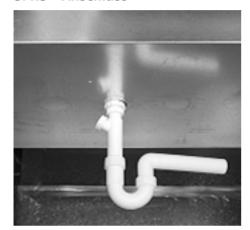
Der Ablauf der Umluft-Kühlwanne Multifunktion führt unten aus der Umluft-Kühlwanne heraus und sollte durch autorisiertes Fachpersonal an eine bauseitige Abwasserleitung angeschlossen werden. Es muss ein Siphon unterhalb der Umluft-Kühlwanne Multifunktion installiert werden, um eine Benachteiligung durch Gerüche zu vermeiden.
