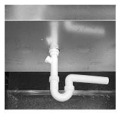
Der Ablauf der Kühlwanne führt unten aus der Kühlwanne heraus und muss durch autorisiertes Fachpersonal an eine bauseitige Abwasserleitung angeschlossen werden. Es muss ein Siphon unterhalb der Kühlwanne installiert werden, um eine Benachteiligung durch Gerüche zu vermeiden.
