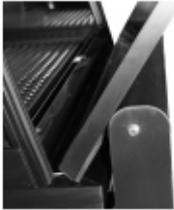
Durch Anheben im geöffneten Zustand kann die Isolierverglasung aus der Arretierung gehoben werden. Beim Einsetzen und Schließen der Isolierverglasung ist darauf zu achten, dass der Scheibenrahmen in geschlossenem Zustand an der Dichtung anliegt.
