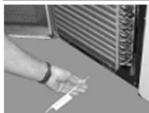
Um das Kälteaggregat vor Beschädigungen während des Transports zu schützen, ist es mit einer Transportsicherung versehen. **Nach dem Aufstellen der Theke die Transportsicherung des Kälteaggregats entfernen und sicher aufbewahren.** Dies gewährleistet ein Freischwingen des Aggregats.
