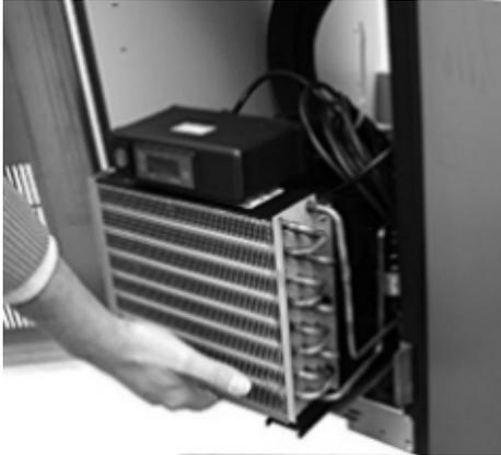
Im **Maschinenfach** steht das Kälteaggregat auf Montageschienen und kann ggf. für Wartungsarbeiten oder Anschlussarbeiten des autorisierten Fachpersonals nach vorne herausgezogen werden. Vor dem Herausziehen des Aggregats muss die Transportsicherung entfernt werden (siehe Kapitel 3).
