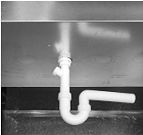
Der Ablauf der Umluft-Kühlwanne führt unten aus der Kühlwanne heraus und muss durch autorisiertes Fachpersonal an eine bauseitige Abwasserleitung angeschlossen werden. Es muss ein Siphon unterhalb der Umluft-Kühlwanne installiert werden, um eine Benachteiligung durch Gerüche zu vermeiden.
