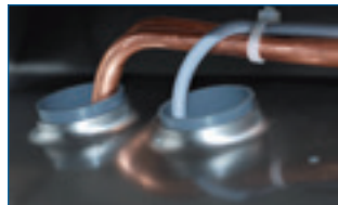
▣ hochgezogene Schutzkragen für Kabel und Kälteleitungen
