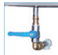
Kugelsperrhahn, Magnetventil (Zulauf)
